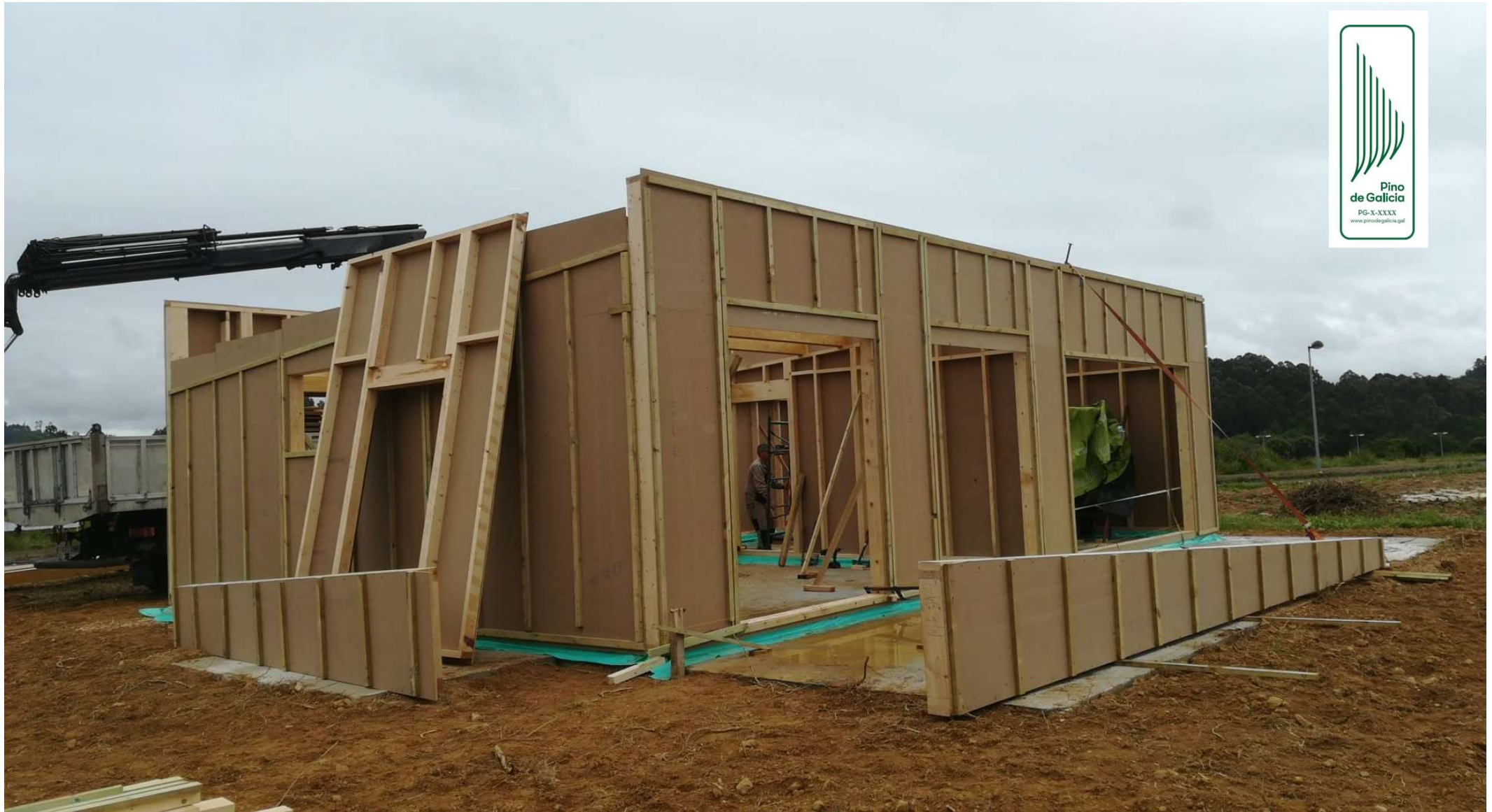
Casas de entramado ligero con madera aserrada estructural de Pinus pinaster y Pinus radiata de Galicia.
