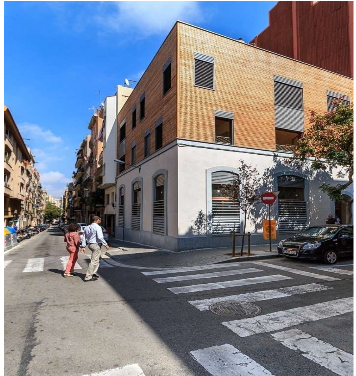
Fachadas en madera termotratada de Pinus pinaster de Galicia.
